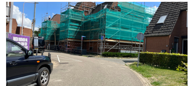
Verduurzaming panden - Woningcorporaties verbeteren de woningen met een lager energielabel.
